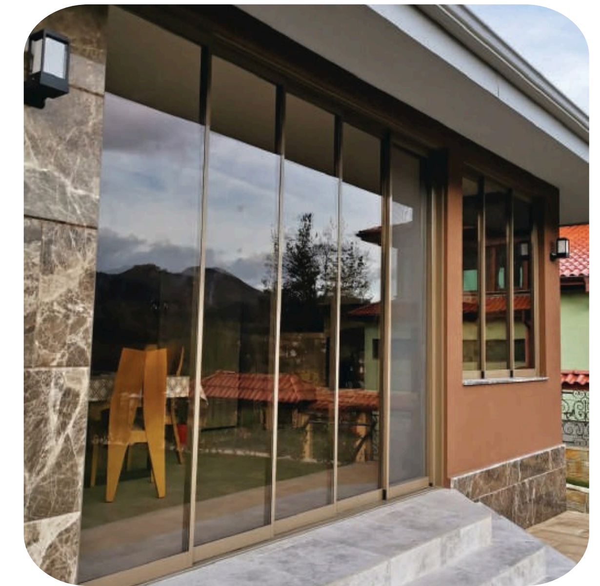
MONTAJ LA EXTERIOR
